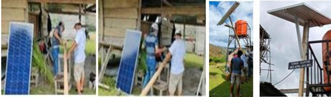
**Gambar 7.** Pengerjaan Rangka, Tiang Penyangga, Pemasangan Panel Surya
